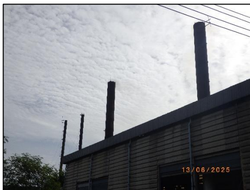
รูปที่ 2-4 เตาเผาขยะมูลฝอยของนิคมอุตสาหกรรมบางปะอิน ที่มีความสูงของปล่อง 20 เมตร
